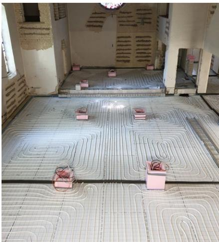
Bild 1: Heizschleifen der Fußbodenheizung
